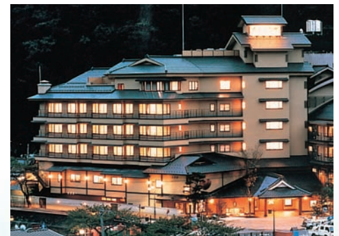
鉄筋コンクリート造の旅館
