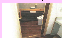
開口幅の拡大・引き戸の設置
